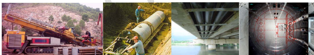
Foto 5 – Figura de les tècniques a emprar en un soterrament d'aquesta magnitud. D'esquerra a la dreta: Perforació horitzontal dirigida, empenta oleodinàmica, utilització de ponts i viaductes, i finalment túnel. Font: [12], [15] i [13].
